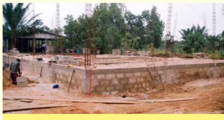
Das Untergeschoss in Djanglanmey ist fertig gestellt.
